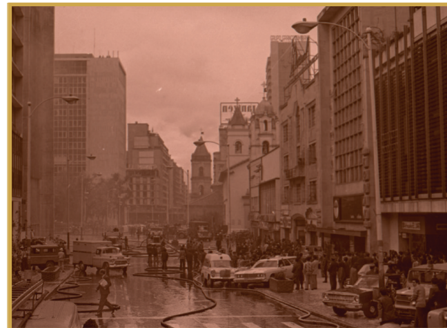
Edificio Avianca. En este grupo de fotografías se observa el incendio del edificio Avianca, ubicado junto al parque Santander. El siniestro ocurrió el 23 de julio de 1973.
