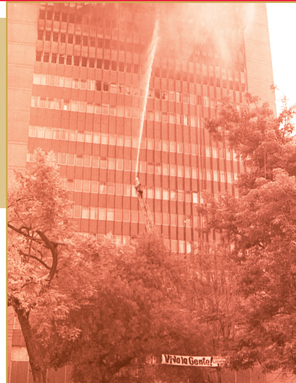
Edificio Avianca. En este grupo de fotografías se observa el incendio del edificio Avianca, ubicado junto al parque Santander. El siniestro ocurrió el 23 de julio de 1973.
