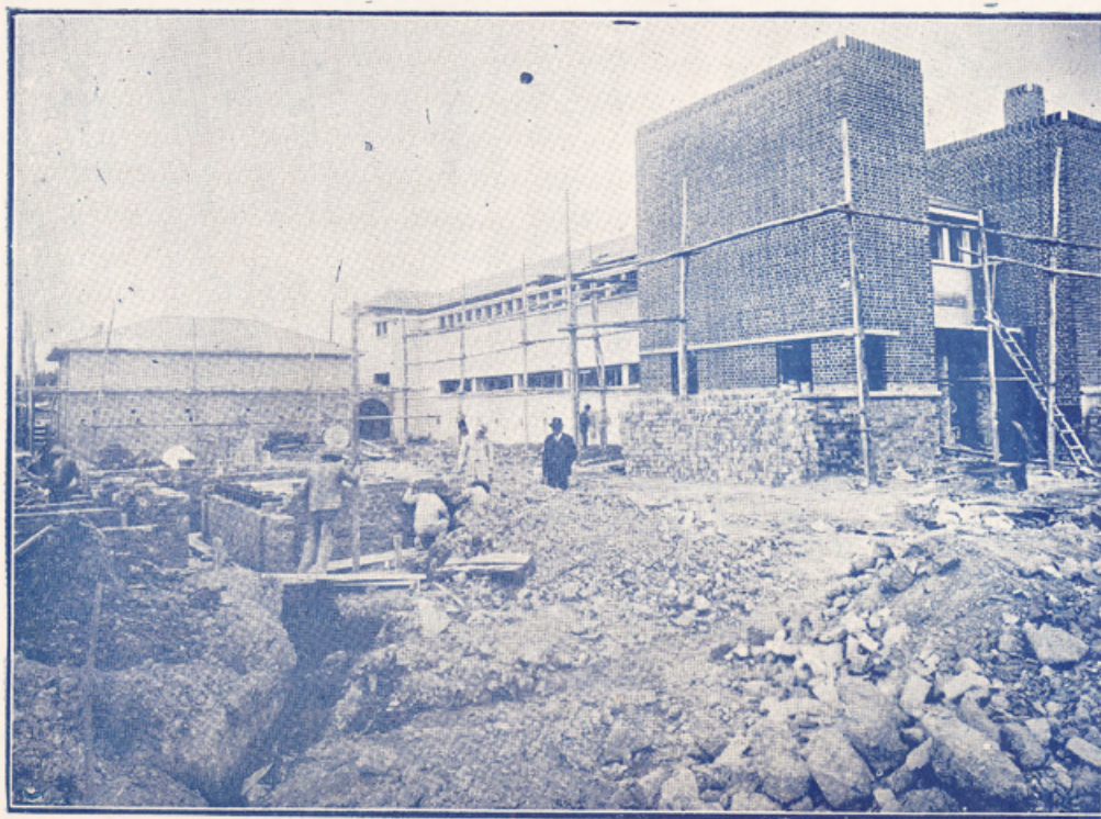
Situada en el barrio Ricaurte. Está actualmente en construcción. Tendrá capacidad para 276 alumnos.
