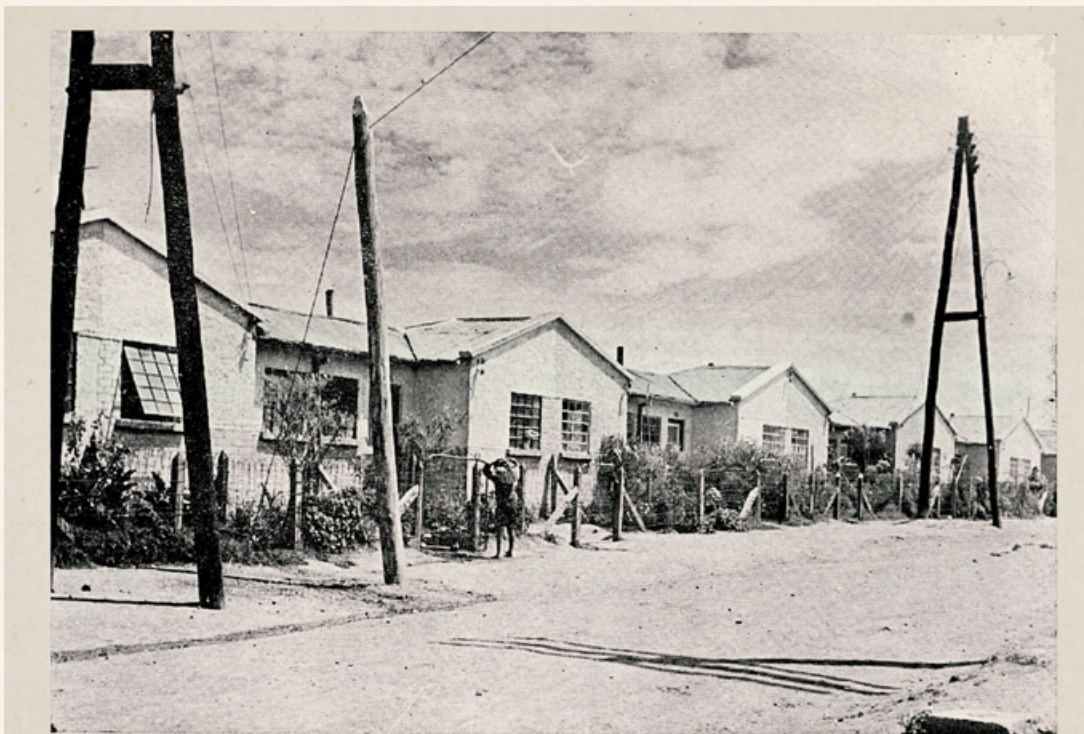
Un grupo de casas del barrio de El Centenario
