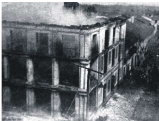
1900 - IMAGEN TOMADA DESPUÉS DEL INCENDIO DE LAS GALERÍAS ARRUBLA, ESQUINA CARRERA 8 CALLE 10.
