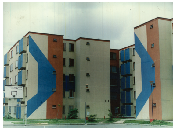
Edificios en construcción de la urbanización Ciudad Favidí, programa de vivienda ubicado en la localidad de Kennedy. Fondo de Ahorro y Vivienda Distrital. Archivo de Bogotá. Ciudad FAVIDI. 603.01.01.01.02.24.
